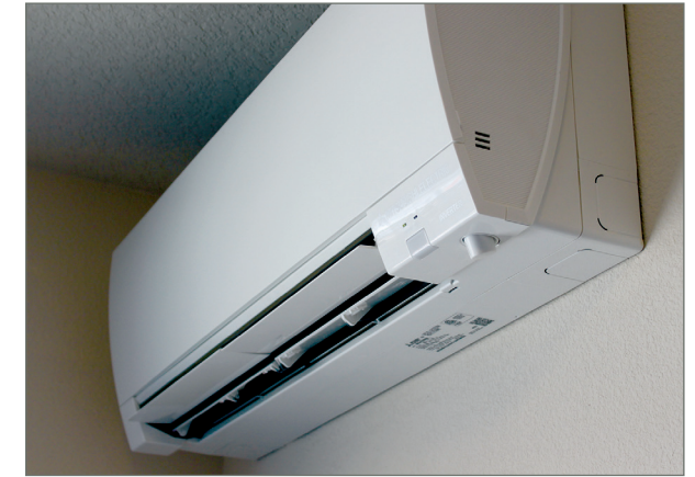
Fig. 34: Mini split heat pump head
