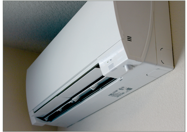
Fig. 34: Mini split heat pump head
