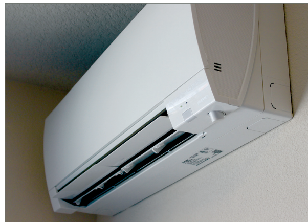
Figura 34: Cabezal de bomba de calor mini-split
