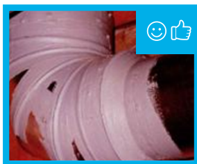
Figura 33: La masilla tiene un espesor de aprox. 1,95 mm (moneda de cinco centavos) y cubre tanto las conexiones como las ranuras para garantizar un sellado hermético.
