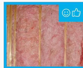
Figura 23: Aislamiento bien ajustado, relleno la cavidad, sin huecos ni grietas.
