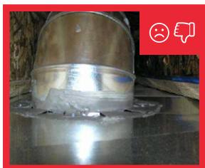
Figura 32: La masilla para sellar conductos se utilizó en una cantidad demasiado fina y no rellena los agujeros.
