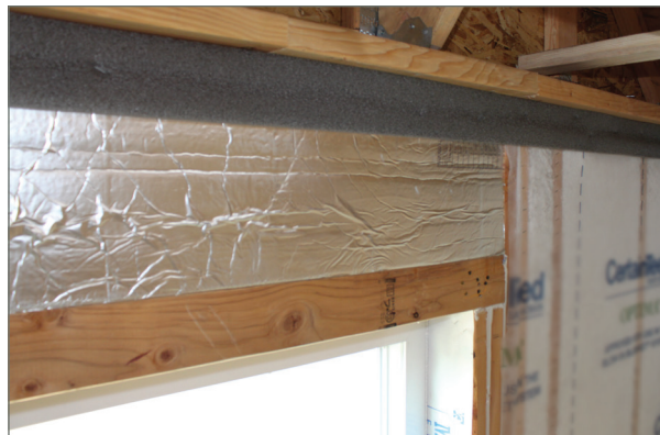
Figura 4: Cabezal aislado
