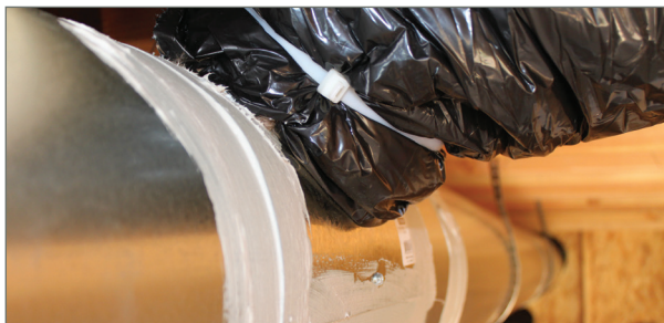
Figura 28: Masilla de aprox. 1,95 mm de espesor (moneda de cinco centavos)
