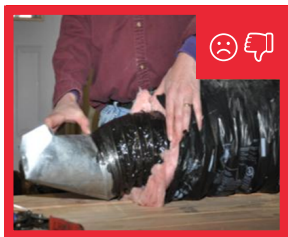
Figura 30: El sello mecánico (correa Panduit o brida) no conecta el conducto flexible a la funda metálica.
