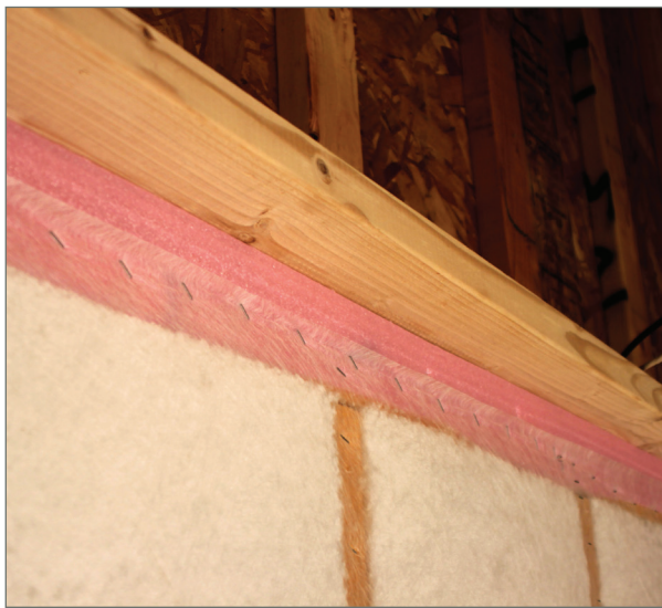
Figura 7: Sellador de umbral de espuma instalado en la placa superior
