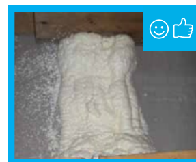
Figura 13: La conexión de la placa superior al panel de yeso está sellada y todos los huecos y grietas están cubiertos.
