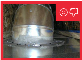
Fig. 32: Se aplicó muy poca masilla para sellar ductos y no cubre bien los agujeros.
