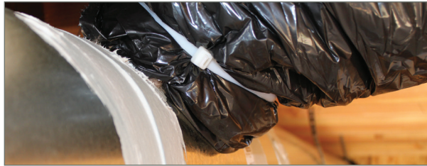
Fig. 27: Los ductos rígidos sellados con pasta masilla y los ductos flexibles ajustados mecánicamente con corbatillas de nylon dentro y fuera de las mangas o cubiertos.
