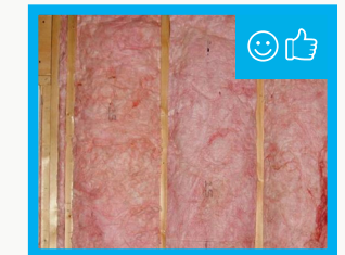
Fig. 23: El aislante bien colocado queda ajustado llenando la cavidad sin huecos o grietas.
