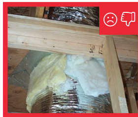
Fig. 10: Las penetraciones alrededor de ductos usando aislante fibroso no sellan el ático contra movimiento de aire a través de las rozas.
