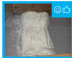
Fig. 13: La conexión entre la placa superior y la tablaroca está sellada así como todos los espacios y grietas cubiertas.
