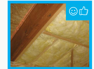
Fig. 25: El aislante se ajusta a modo que quede apretado sin huecos o grietas y llene la cavidad.
