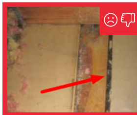
Fig. 12: La placa superior que conecta al ático no está sellada contra el aire que fluye hacia el interior de la pared.
