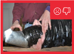
Fig. 30: El sellado mecánico (tira de Panduit o de corbata nylon) no está conectando el ducto flexible a la bota metálica.
