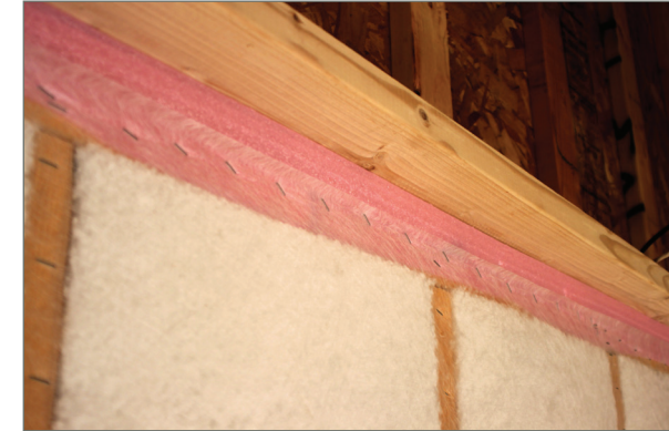
Fig. 7: Sellador de espuma en umbral, instalado en placa superior
